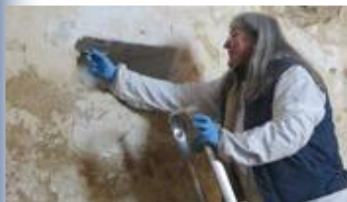
Mme V. Legoux dépoussiérant une zone d'enduit.
